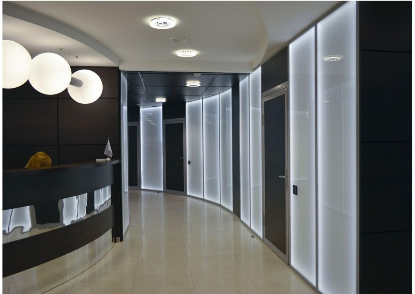
В каркасных перегородках с двойным остеклением возможна установка межрамных горизонтальных жалюзи. Как правило, в этом случае, горизонтальные межрамные жалюзи также устанавливаются внутри дверных полотен с двойным остеклением. Далее приведены примеры реализации каркасных перегородок с двойным остеклением и применением различных системных профилей и указаны рекомендуемые значения высоты перегородок при шаге стоек до 1,0 и 1,3 метра. При реализации перегородок
